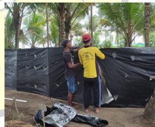
Pemasangan pematah angin
